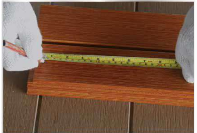
2. วัดระยะเพื่อกำหนดจุด ตามระยะโครง 40 ซม.
