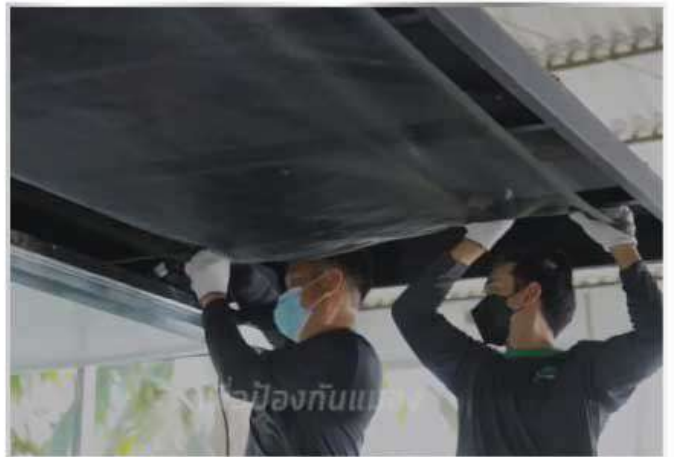
4. ติดตั้งตาข่ายกันแมลงกับโครงเหล็ก ก่อนการติดตั้งไม้ระแนง เพื่อป้องกันแมลงหรือสัตว์ร้ายเข้าไปอาศัยอยู่
